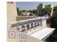
Balaustrado de barro con capas de pintura deteriorada, ausencia de pinturas.
