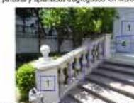
Presencia de pintura en mal estado en balaustrado de concreto, cantos y desgaste en el canto de terrazo.
