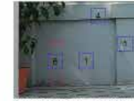
Presencia de grietas, humedad y deterioro de pintura en muros.
