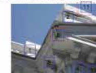
Cornisa de lámina con capas de pintura en mal estado y separación en lámina.
